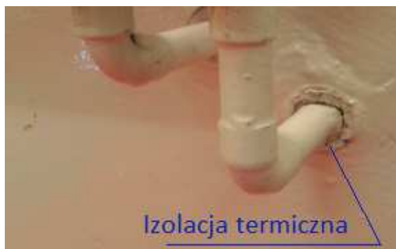
Zdj.: Przewody doprowadzające czynnik grzewczy do grzejników – w izolacji termicznej, w bruździe ściennej.
