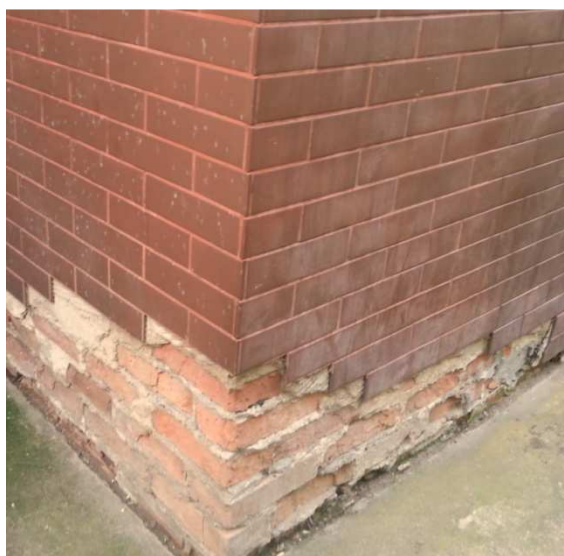
Zdj.: ściana trójwarstwowa
