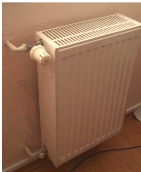
Zdj.: Grzejnik płytowy, stalowy, wyposażony w głowicę termostatyczną.
