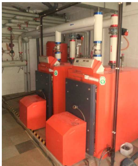
Zdj.: Kotłownia olejowa, 2 kotły Viessmann o mocy 130 kW.
