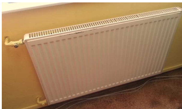
Zdj.: Grzejnik płytowy, stalowy, niewyposażony w głowicę termostatyczną.
