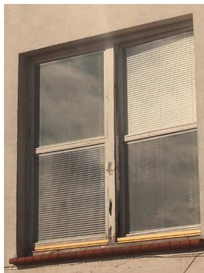
Zdj.: Okna stare, drewniane (większość okien), niewymienione.
