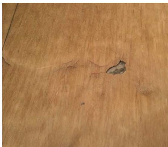
Zdj.: Warstwa wykończeniowa posadzki w jednej z sal dydaktycznych, w złym stanie
