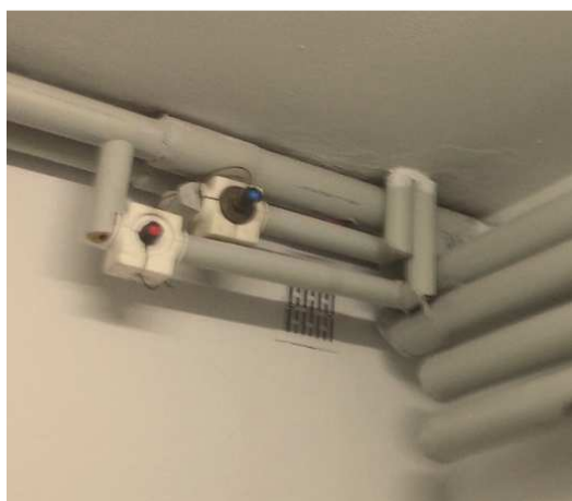
Zdj.: Zawory regulacyjne podpionowe, przewody poziome C.O. w izolacji termicznej.
