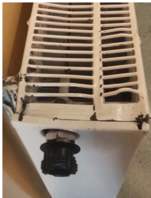
Zdj.: Stary grzejnik, niewyposażony w głowicę, ani zawór termostatyczny.
