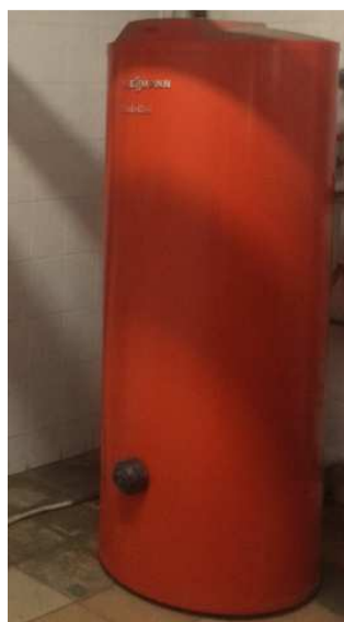
Zdj.: Zbiornik buforowy c.w.u. zlokalizowany w kotłowni.
