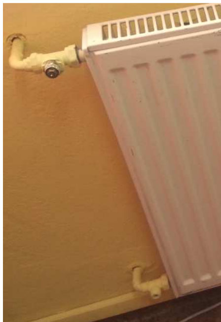
Zdj.: Stary grzejnik, niewyposażony w głowicę termostatyczną.
